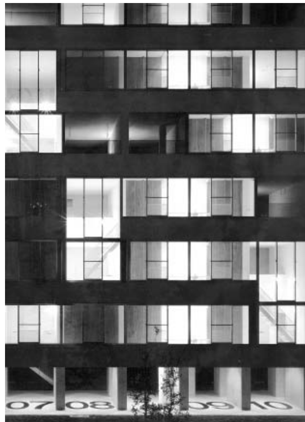
Vista da fachada oposta à circulação coletiva
