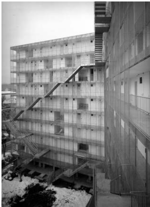
Vista da fachada com circulação coletiva
