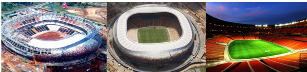
Obras do principal estádio, o Soccer City, duraram três anos
