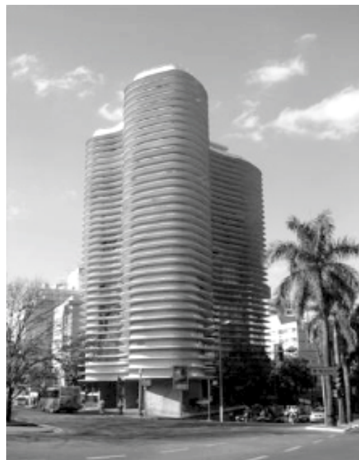
Vista geral do edifício
